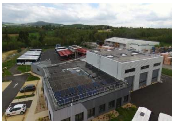
Dépôt de bus avec installation Photovoltaïque - A Nos Watts
