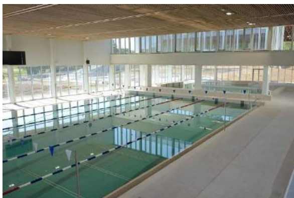
Centre aquatique Aquavaure - Agglo
