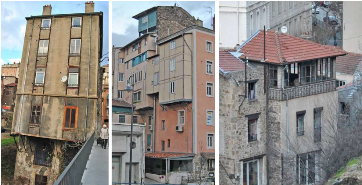
Séchoirs, avancées de façade réalisés en bois
