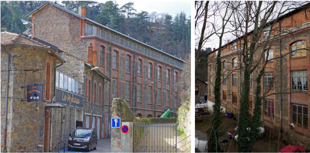
Quelques usines occupées : chemin des Falcons et vue depuis le pont du C.D.n°270 d'Annonay à Sarras.
