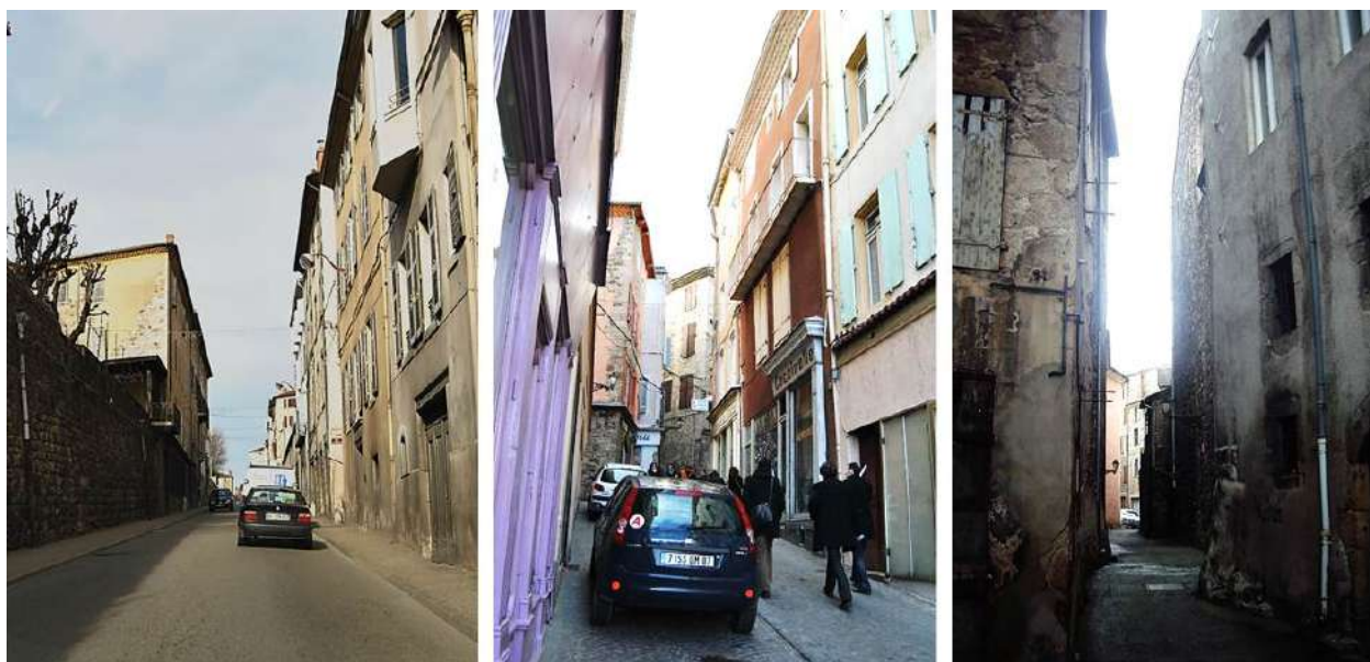
De gauche à droite: rue Melchior de Vogüe, une des principales artères qui entourent le centre ancien ; rue Franki Kramer, axe médiéval structurant, mais où la circulation et le stationnement automobiles ne sont ni adaptés ni justifiés en raison de l'étroitesse du tissu et de l'offre de stationnement très importante à proximité immédiate ; rue du Docteur Barry, ruelle médiévale particulièrement dévalorisée actuellement
