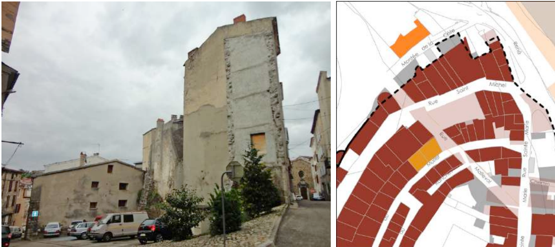
L'îlot formé par les rues St-Michel et Malleval a fait l'objet de démolitions en raison de l'état de dégradation du bâti. L'espace laissé libre est occupé par du stationnement sauvage et un transformateur, et laisse à voir les pignons et arrachés de maçonnerie - extrait de plan 1/2000
