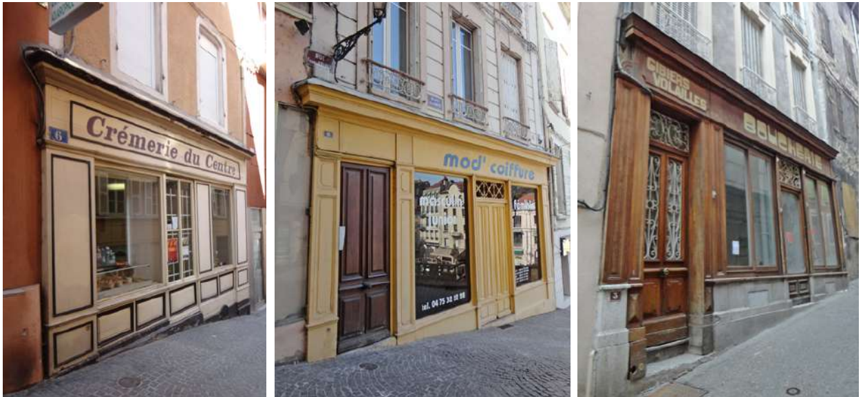
Façades menuisées commerciales XIX e - de g. à d.: 6, rue Franki Kramer, 6, place de la Liberté, 3, rue Jean-Baptiste Bechetoille
