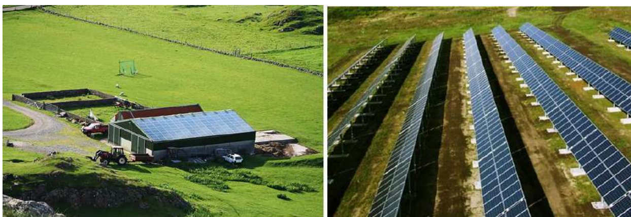
A gauche, exemple de panneaux photovoltaïques sur un bâtiment agricole. Source : saint-gobain-solar.com – à droite, exemple de panneaux photovoltaïques posés au sol. Source : energreen.be
