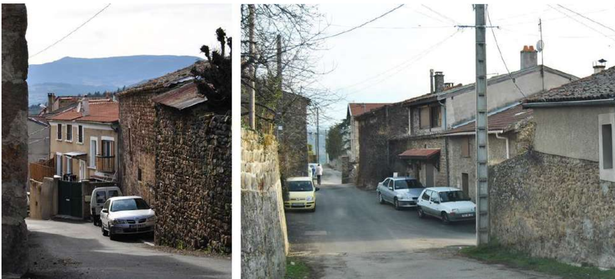
L'implantation du bâti se fait quasi exclusivement sans recul par rapport à la voie. Le souci de l'économie des terres agricoles était particulièrement prégnant à l'époque de l'implantation.
