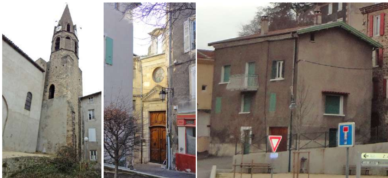
De g. à dr. : la chapelle de Trachin édifée en 1320 puis remaniée au XVIII e siècle ; l'église réformée située rue Franki Kramer à l'emplacement supposé de l'ancien hôpital de l'Aumône ; l'emplacement de l'ancienne chapelle St Claude.
