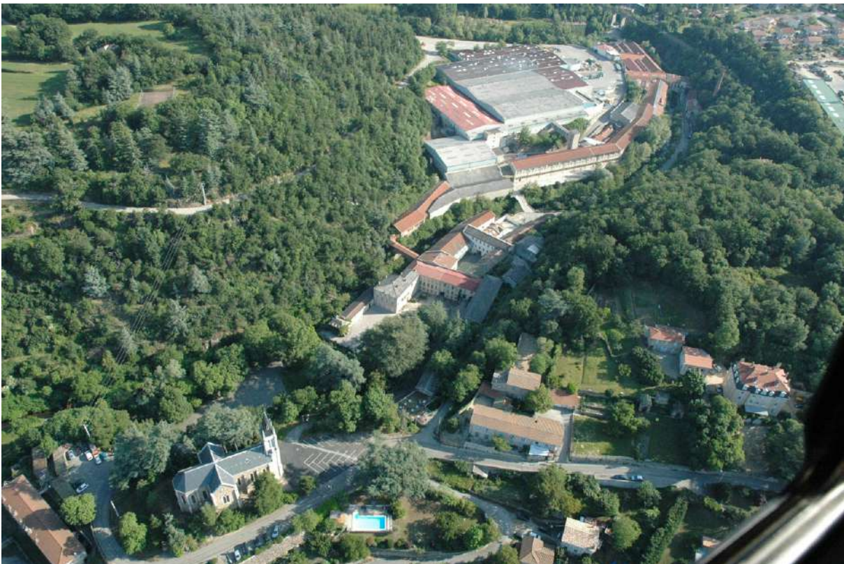
Les papeteries Canson Montgolfier – vue oblique.
