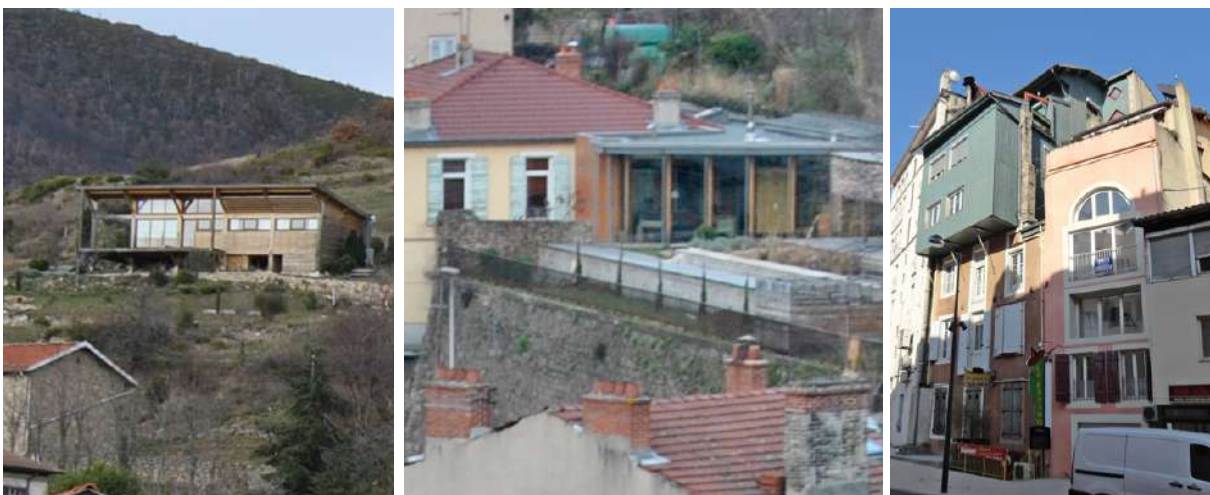
Constructions ou extensions récentes réalisées en bois.
